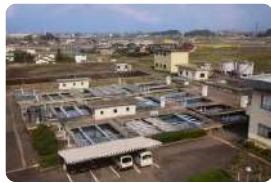
廃止される古賀市浄水場
