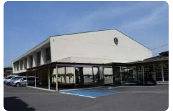
古賀東中学校体育館
